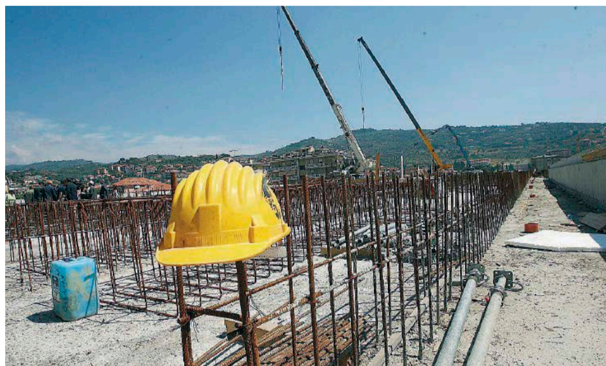
Crisi occupazionale nell'area della Sibaritide La riapertura dei cantieri darebbe respiro all'economia dell'Alto e Basso Ionio
